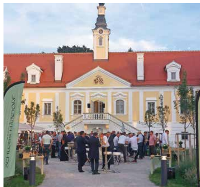
Das renovierte Hotel Schloss Haindorf als Sitz der BAUAKademie NÖ bei der feierlichen Eröffnung am 12.9.2023.
