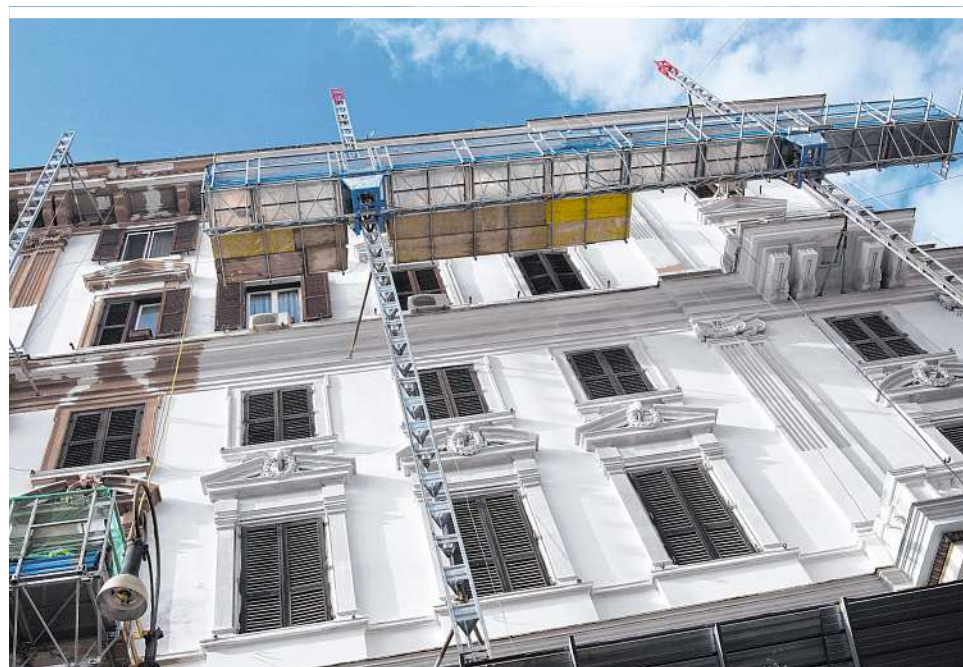
Die Sanierung der Gebäudehülle trägt zur Verbesserung der Energiekennzahlen bei
