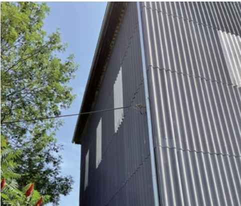
Fassade mit Asbestzement-Wellplatten
