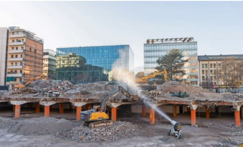
Abbruchbaustelle mit Wasser-Besprühung zur Staubbindung.
