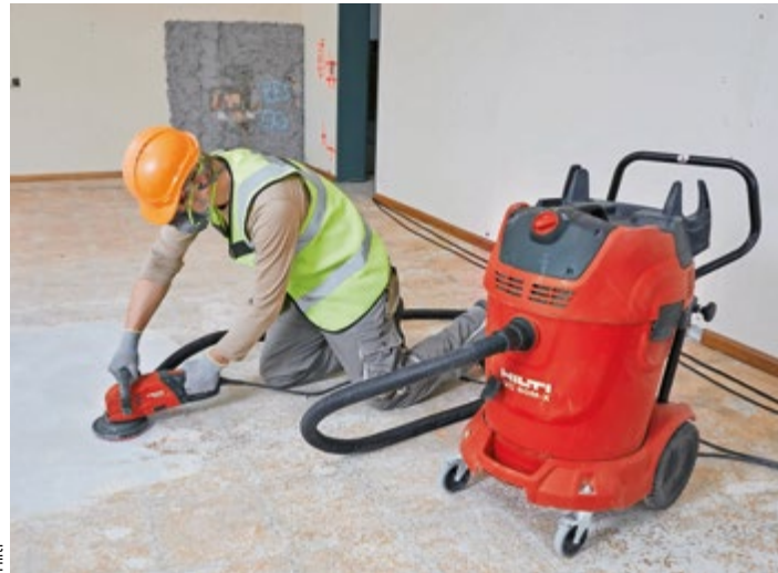
Schleifgerät mit Absaugung.
