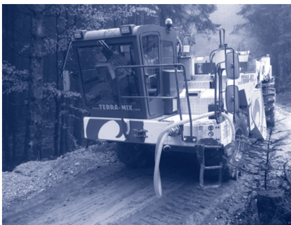
Fräsearbeiten beim Einarbeiten von Holzrasche im Forstwegebau
