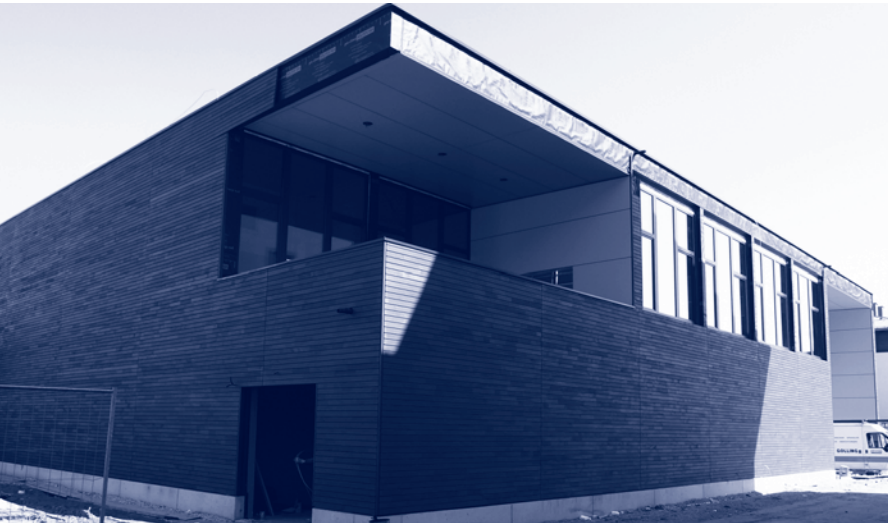
Neue Turnhalle am Holztechnikum Kuchl in Holzbauweise
