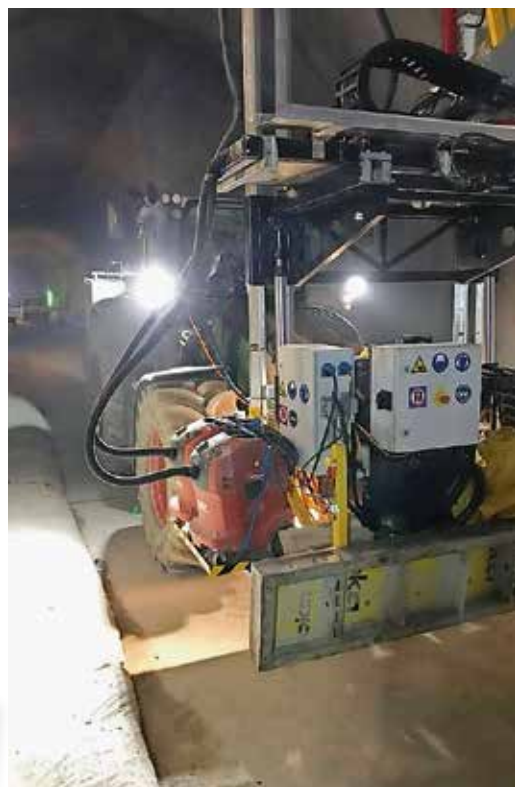
Staubabsaugung bei Bohrlafette im Tunnelbau.
