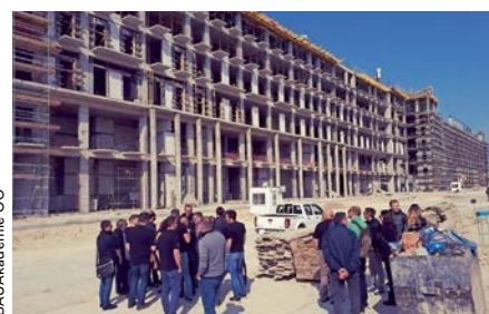
Baustellenbesichtigung im Rahmen der Studienreise nach Kasachstan 2019
