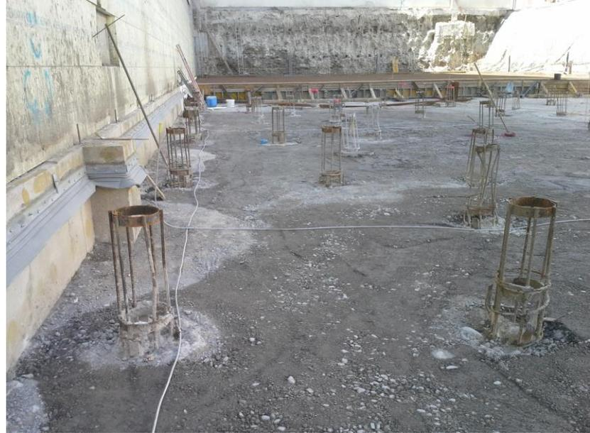
Auf Grund der Betongüte muss möglicherweise schon vor der Sauberkeitsschicht der Nirosta-Anlageerder verlegt werden!
