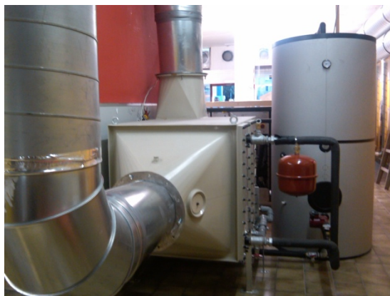
Abbildung 50: Fotobeispiel für Abluftwärmetauscher im Münzwaschsalon
