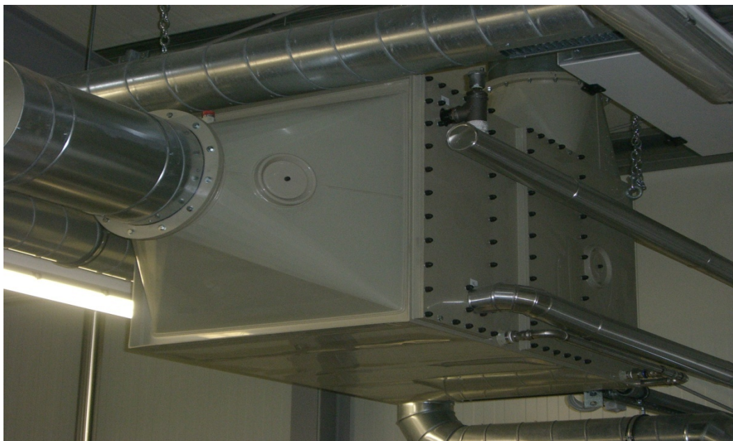
Abbildung 49: Fotobeispiel für Abluftwärmetauscher im Mischbetrieb (Tageskapazität ca. 300 kg Oberbekleidung und Wäsche)
