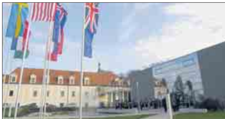
Die NÖ BAUAkademie und das Schloss Haindorf.
