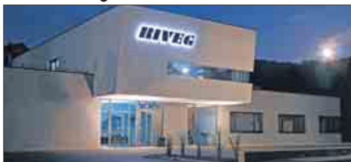
Das neu errichtete repräsentative Bürogebäude der RIVEG-Treuhand GmbH in Scheibbs.
