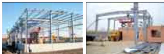
Abb.: MEROBA Produktionshalle 900m 2 , Bürogebäude in Massivbauweise mit 250m 2
