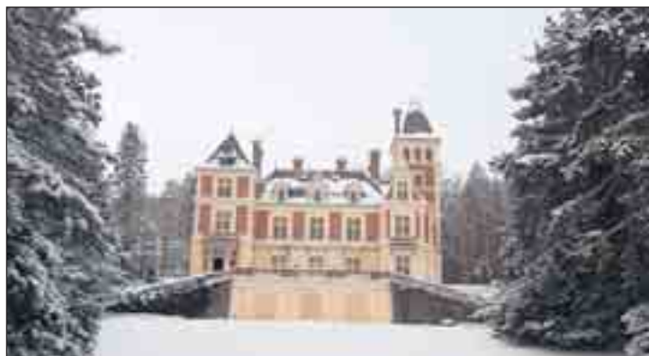
Im einst kaiserlichen Schloss Wartholz hat jetzt die Literatur einen hohen Stellenwert.
