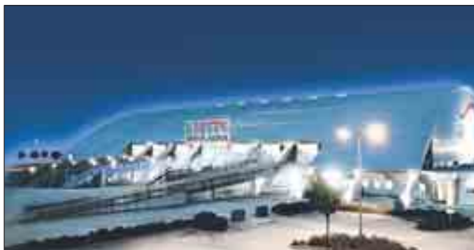
Foto: Arena Nova
