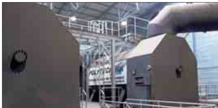
2 x 16.100 kW Polytechnik-Dampfkraftanlage (7500 kWel) in Südfrankreich.
