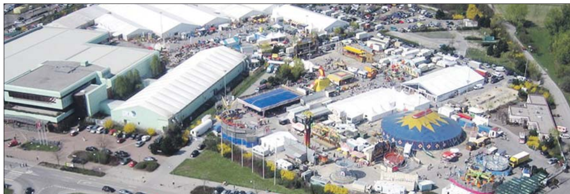
Das Veranstaltungszentrum (VAZ) in St. Pölten beherbergt von 11. bis 14. April die WISA, wo in 13 Hallen und auf dem Freigelände voll auf das Thema Bauen und Sanieren gesetzt wird.
