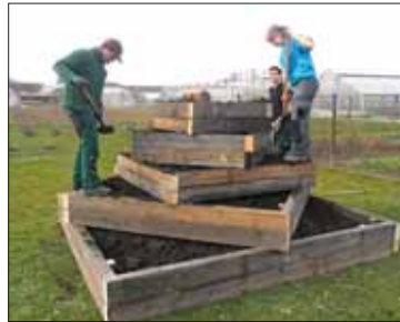
Fotos unten: Die Erdäpfelpyramide – „Rohbau“ und Fertigstellung.
