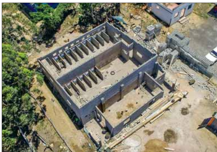
Das Projekt: Gemeinsam mit einem lokalen Bauunternehmen wurden die Sanitäranlagen in der einzigen Schule des Ortes auf europäischen Standard gebracht.
