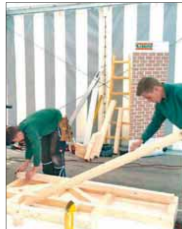
Innerhalb von zwei Tagen wurde das Spielhäuschen gefertigt.
