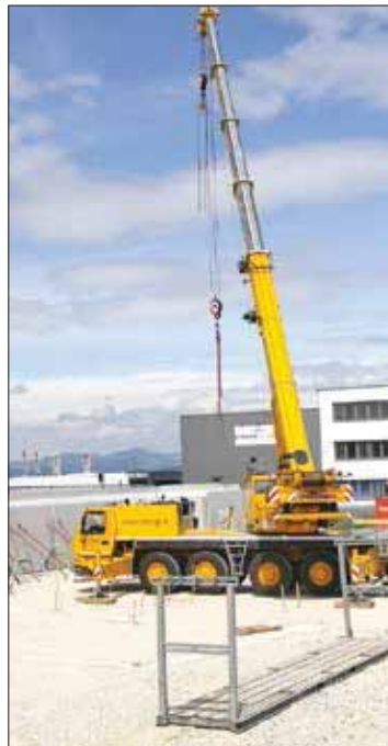
Während der Bauarbeiten: schweres Gerät statt Spaten.
