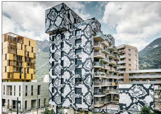
Die Grenoble-„Python“ – PREFA macht's mit 47.000 Wandrauten möglich. Foto: PREFA Aluminiumprodukte GmbH
