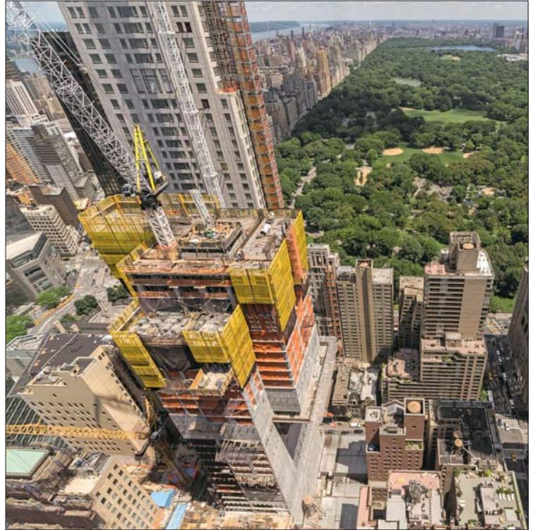
An der Südseite des Central Park entsteht das höchste Wohnhaus der Welt. Es wird mit Technik aus Amstetten gebaut, der Selbstkletterplattform Super Climber von Doka.
