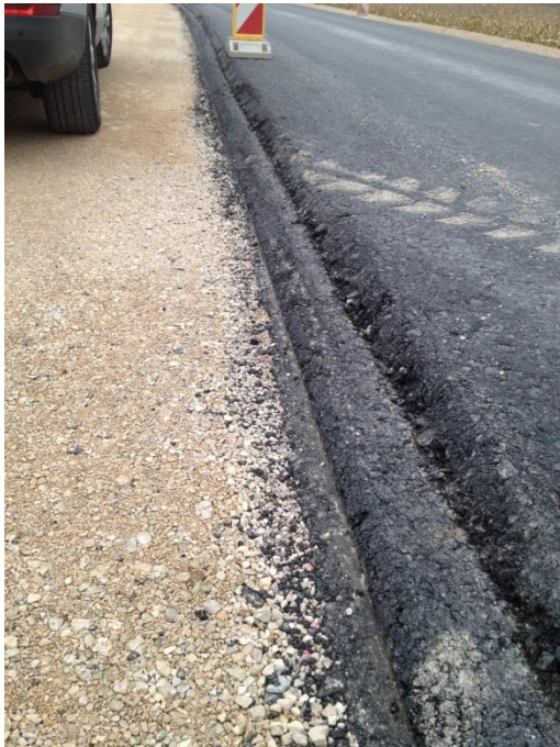
Aufbringen der Asphaltschicht
