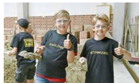
Von „Baulöwe“ bis „Betonmuskel“: Volksschüler zeigten im Lehrbauhof, wie geschickt sie mit Mörtel und Kelle umgehen können.
