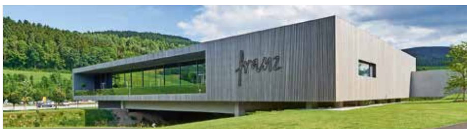
Das Betriebsrestaurant Franz in Thomasberg sicherte sich Platz eins beim NÖ Baupreis 2018.
