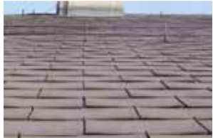
Fassaden und Dächer aus Asbestzement
