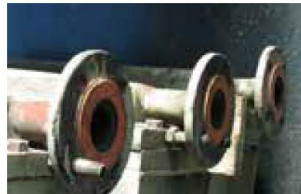
Asbesthaltige Dichtungen
