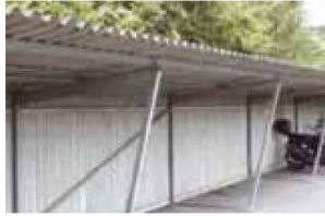
Asbestzementwellplatten
