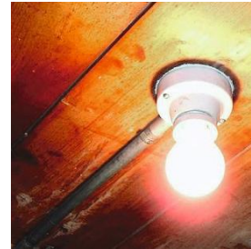
Asbesthaltiger Mörtel zur Rohrisolation
