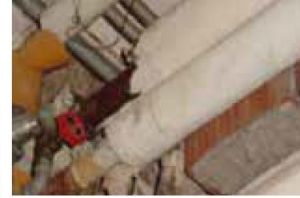
Asbesthaltiger Mörtel zur Rohrisolation
