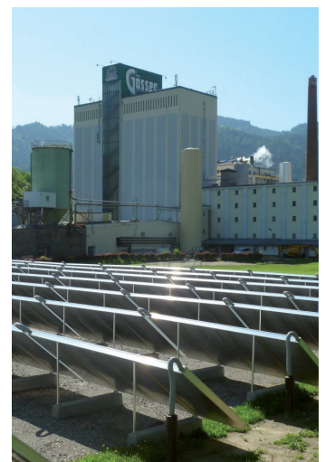
Solaranlage in Göss
