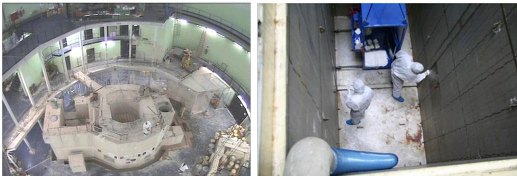
Abbildung 2: Rückbau des Forschungsreaktors ASTRA und des Brennelementlagerbeckens
