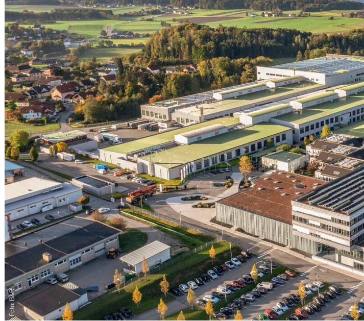
B&R Campus stellt mit neuer Industriewärmepumpe und Photovoltaik-Ausbau die Weichen für die Klimaneutralität
