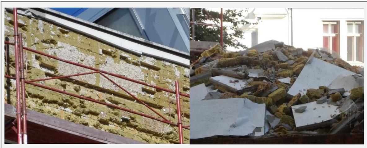
Abb. 3-6: *Aufwändiger Rückbau eines Fassadensystems aus Holzwolle-Mehrschichtplatten<sup>88</sup>*
