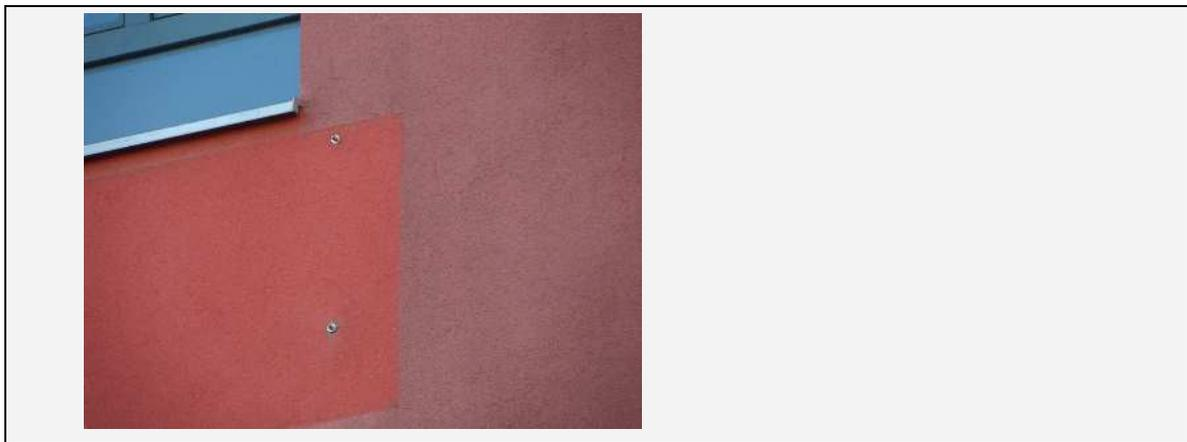
Abb. 3-11: *Ausbleichung einer Fassade*<sup>122</sup>
