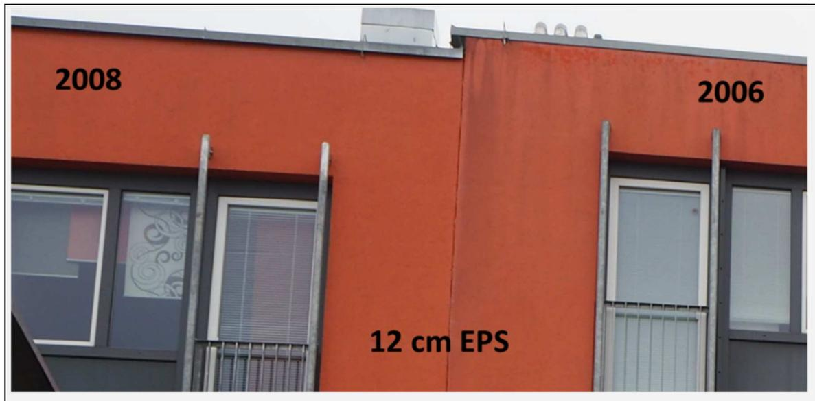
Abb. 4-23: *Unterschiedliche Veralgungsgrade (links Baujahr 2008, rechts Baujahr 2006)*
