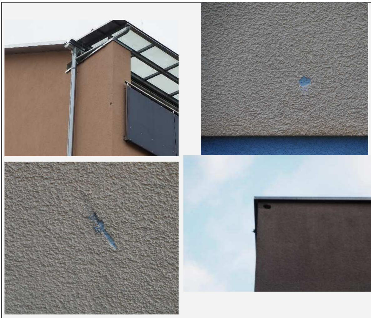
Abb. 4-14: *Mechanische Beschädigungen*
