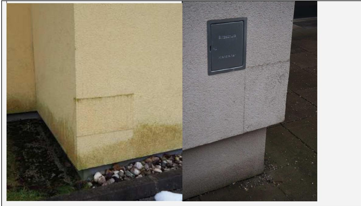
Abb. 4-15: *Ausgebesserte Beschädigungen*
