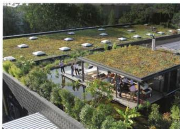
So kreativ ist die Arbeit von Dachdeckern und Spenglern.
