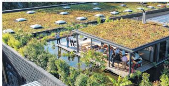
So kreativ ist die Arbeit von Dachdeckern und Spenglern.
