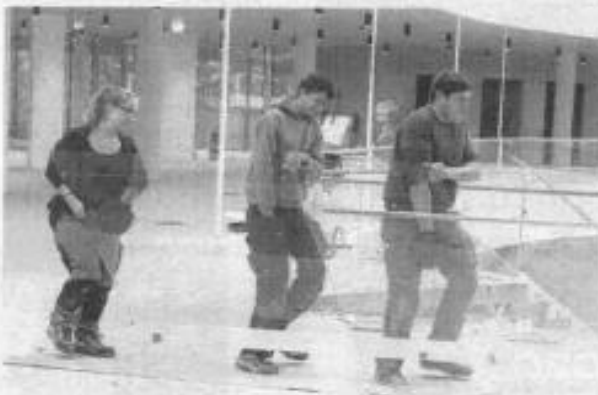
Glas Bauer erledigte für KTM die Brüstungsarbeiten im neuen „House of Brands“ – höchster technischer Anspruch war gefragt. Foto: Glas Bauer (D)
