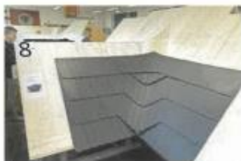
Das Wettbewerbsmodell der Dachdecker war eine Herzkehle mit Steinschindeldeckung.
