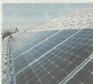
Dachdecker- und Spengler sind auch in Energiefragen/Dachbegrünung kompetente Ansprechpartner Foto: DOMICO
