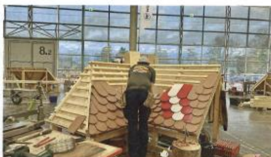
Am ersten Wettbewerbstag musste eine Biberschwanz-Doppeldeckung (Wienerberger) hergestellt werden.
