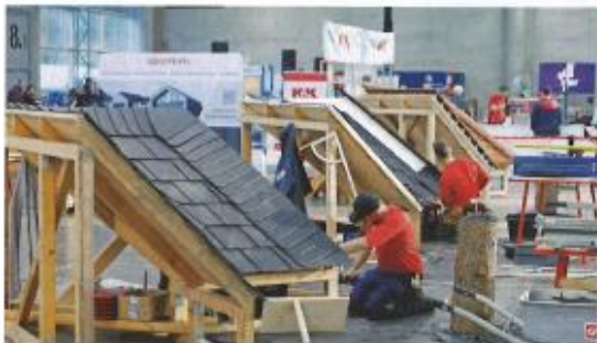
An Tag zwei und drei mussten die sieben Teilnehmer eine Faserzementindeckung (Swisspearl) mit einer Herzkehle ausführen.
