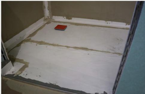
Das Verkleben der Systemkomponenten, wie z. B. Dichtbänder oder Formteile, muss entweder mit der Verbundabdichtung oder mit einem im System geprüften Klebstoff wassererdicht erfolgen.
