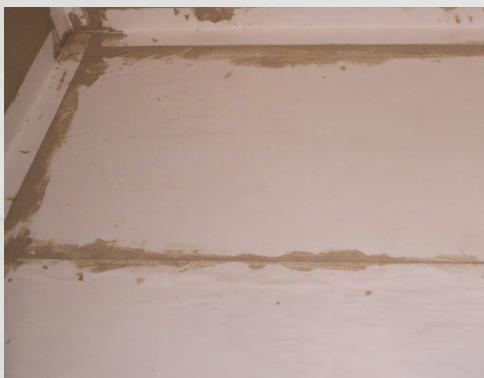
Im Stoßbereich sind die einzelnen Abdichtungsbahnen überlappend anzubringen (mind. 5 cm Überlappung) und mit der Verbundabdichtung oder mit einem im System geprüften Klebstoff (MS Polymer) wassererdicht zu verkleben.
