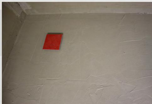
„Frisch in Frisch“ wird die Verbundabdichtung mittels geeigneter Zahnpeschpel auf die Kontaktsschicht aufgezogen.
