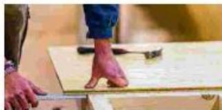
Holzbaumeister fertigen Holzkonstruktionen im Werk millimetergenau vor.
