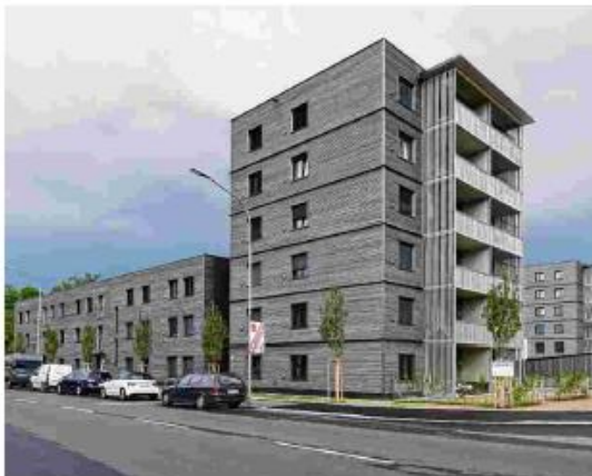
Vergangene Woche war schließfertige Baufassade im ersten der beiden Gebäudekomplexe aus Holz. Foto: Walter Bernhart
