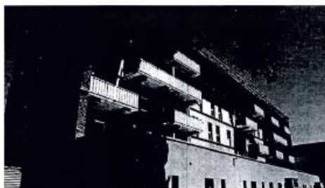
Ab 1. Juli braucht man für Holzbauten wie dieses Haus keine Sondergenehmigung mehr. Die Holzelemente dieses 5-geschossigen Wohnbaus in Leonding wurden in nur drei Wochen montiert.
