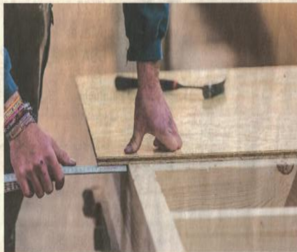
Holzbau-Meister fertigen Holzkonstruktionen im Werk millimetergenau vor.
