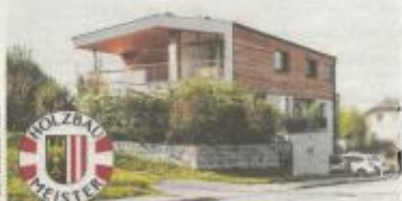
Holzbau; Mittermayr GmbH / Planung: lassy architektur + raumplanung ZT-GmbH
