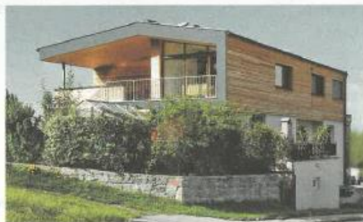
Holzbau: Mittermayr GmbH / Planung: lassy architektur + raumplanung ZT-GmbH © m-haus/Walding 08
