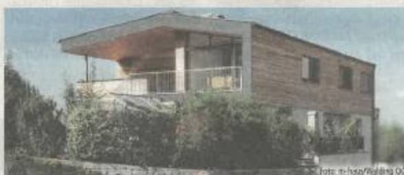
Holzbau: Mittermayr GmbH / Planung: lassy architektur + raumplanung ZI-GmbH
