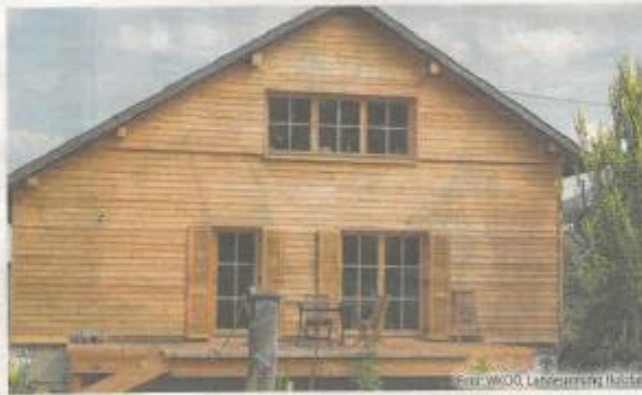
Thermische Sanierung mit Holz: interessante und nachhaltige Alternative
