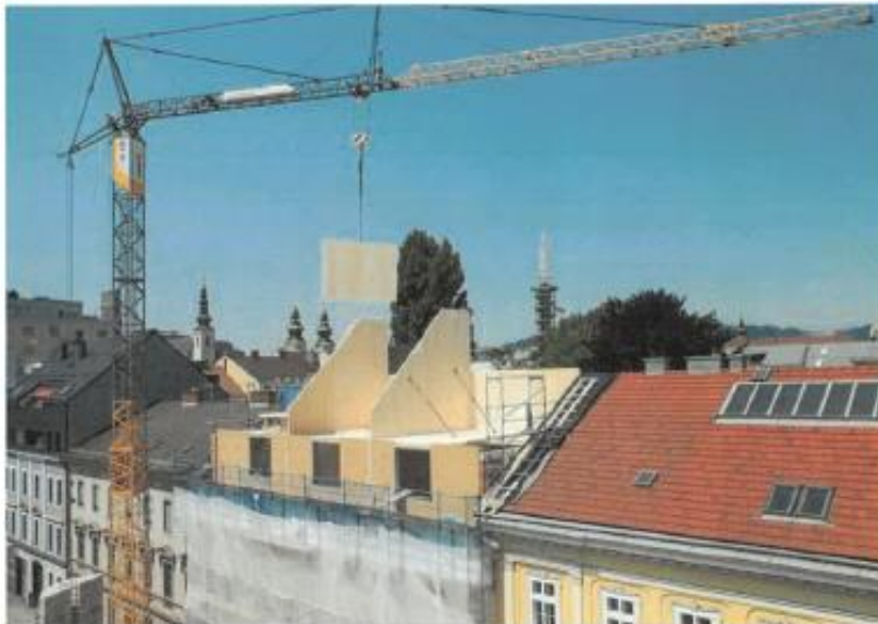
Aufbauten und Erweiterungen in Holzbauweise bieten im städtischen Bereich viele Vorteile. Foto: WK OÖ hochgeladen von Julian Kern
