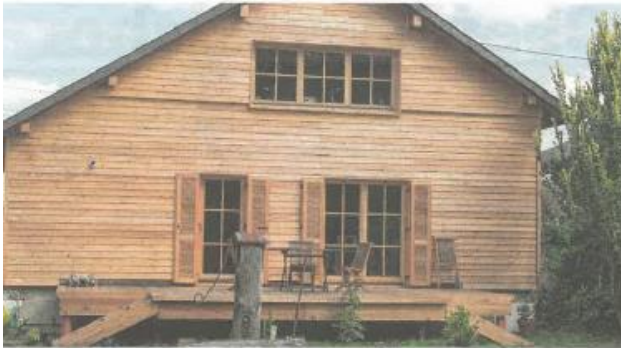
Vom hässlichen Entlein zum schönen Schwan: In St. Peter/Hart steht ein Paradebeispiel, wie mit dem klimafreundlichen Baustoff Holz aus einem unscheinbaren Haus ein wahrer Blickfang wird.
