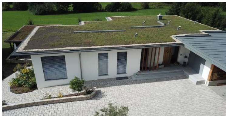
Flachdächer bieten Platz für Begrünungen und Fotovoltaikanlagen. Der Dach-Profi entscheidet über die Tragfähigkeit.
