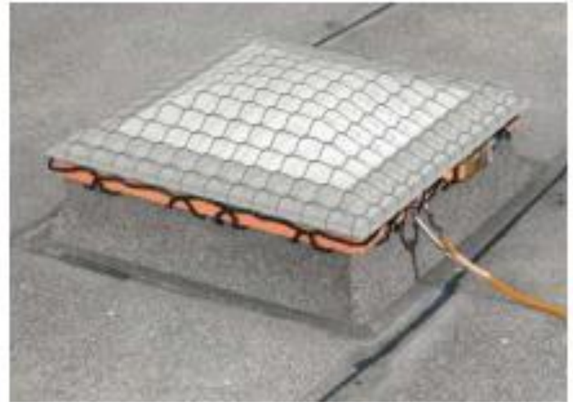
Sicherung von Dachöffnungen
