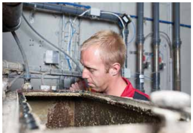
Auch Flüssigfütterungsanlagen sollen regelmäßig gereinigt und mit geeigneten Mitteln desinfiziert werden (Quelle: Fraukoeppl).
