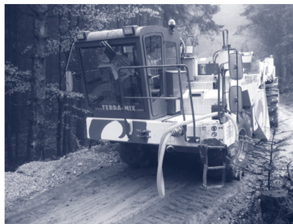
Fräsearbeiten beim Einarbeiten von Holzasche im Forstwegbau
