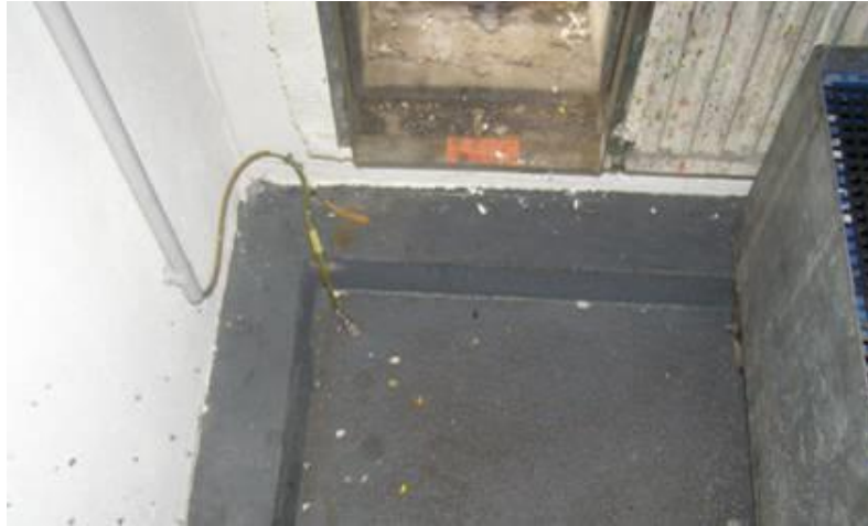
Elektrostat. Ableitende Bodenbeschichtung
