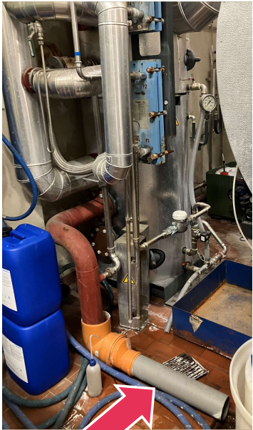
Dampfsystem: 70°C ungenutztes Abwasser 8500 h/a
