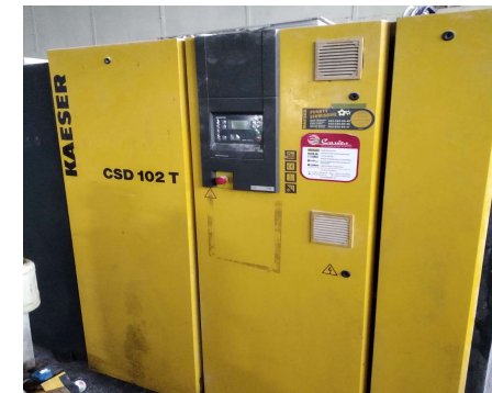
Druckluft: Reduktion Leerlaufanteil (Standby-Verluste) an Kompressor: 62.700 kWh/a Strom bzw. 8.600 €/a
