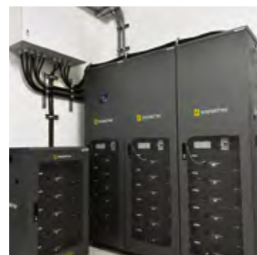
espeicher 45 kVA-120 kWh Logistikzentrum
