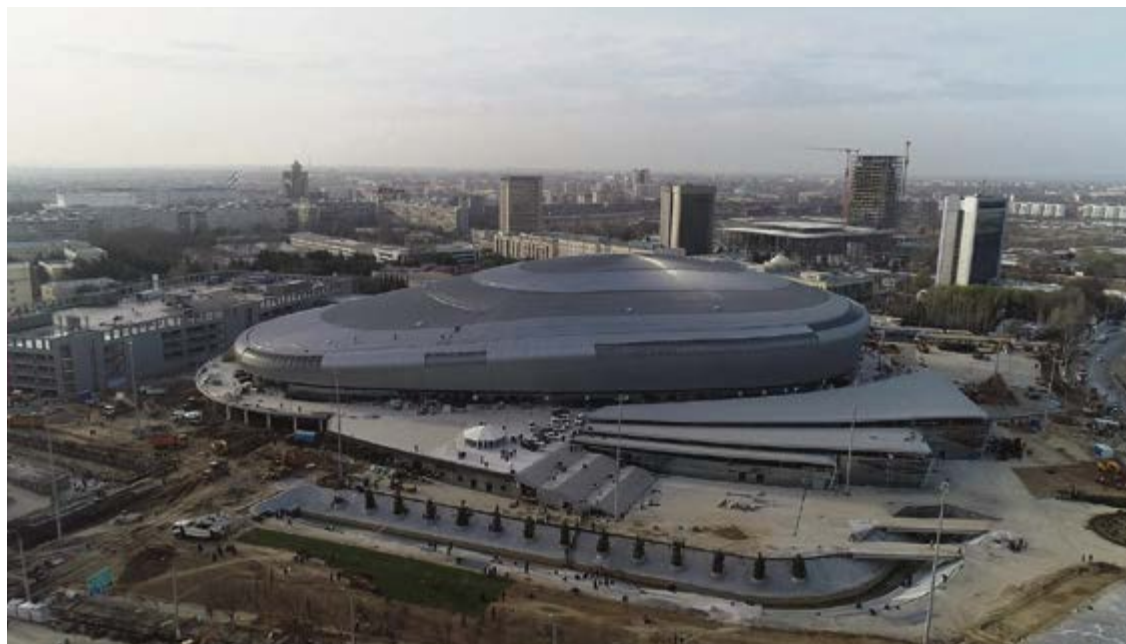
Oberhofer Stahlbau hat in den vergangenen Jahren immer wieder spektakuläre Großprojekte umgesetzt. Für eine Eishalle in Usbekistan lieferte das Unternehmen die größte Stahlkonstruktion Zentralasiens.
