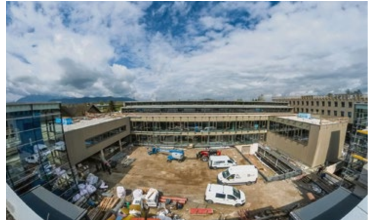
Letzte Arbeiten am neuen „Campus Klessheim“, der zu Schulbeginn im Herbst fertiggestellt wird.
