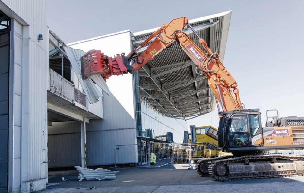
Am Flughafen Salzburg sind Mitte September die Bagger aufgefahren: Der 1966 errichtete Hangar 2 wird abgerissen.
