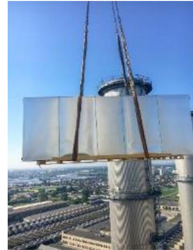
Innovative Kranmontage bei hohen Windgeschwindigkeiten in 70 m Höhe
