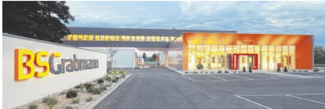
Seit 2014 setzt BS Grabmann die Erfolgsgeschichte am neu errichteten Standort an der B3 in Arbing fort.
